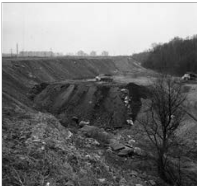
Areál pískových dolů při zavážce stavebním a průmyslovým odpadem, 1981. Fotografie Archiv Vítkovice, a. s.
