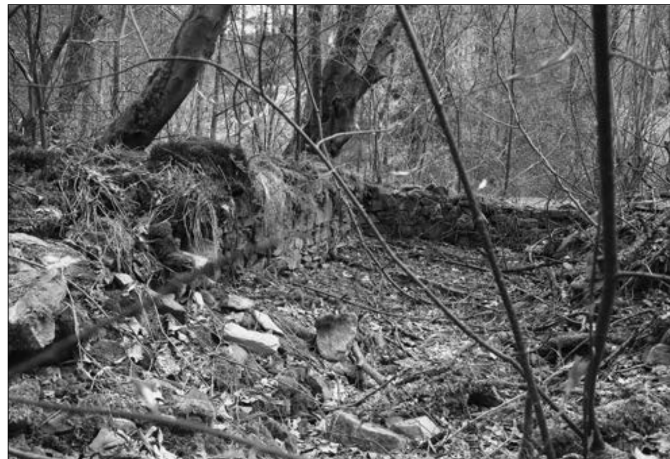
Kamenné základy části budovy Dolního mlýnka. Foto Emil Mateiciuc, r. 2022.
