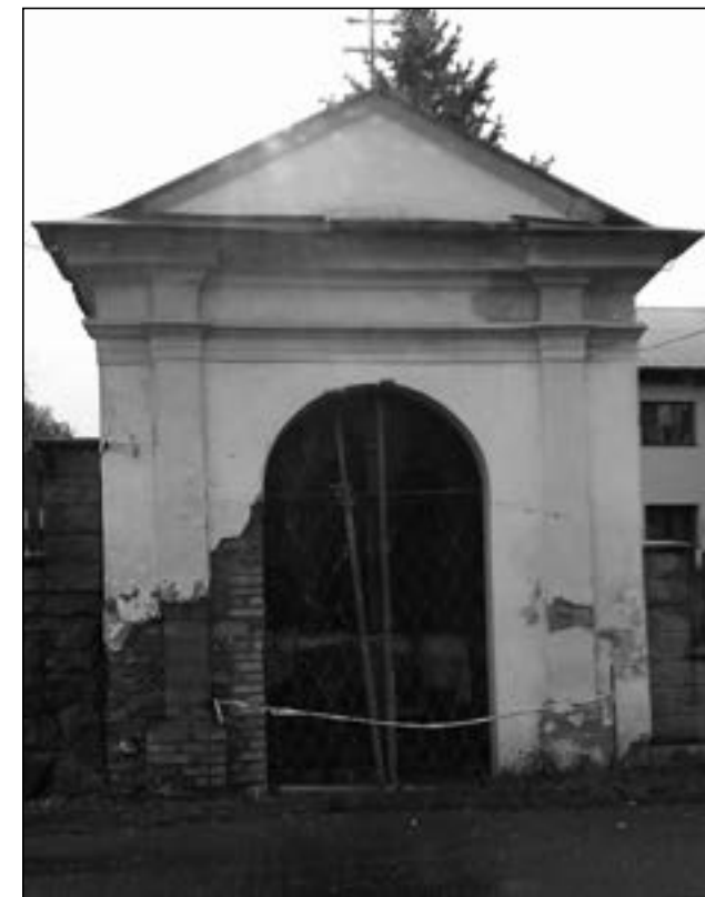
Fotografie z prosince 2018 před opravou.
