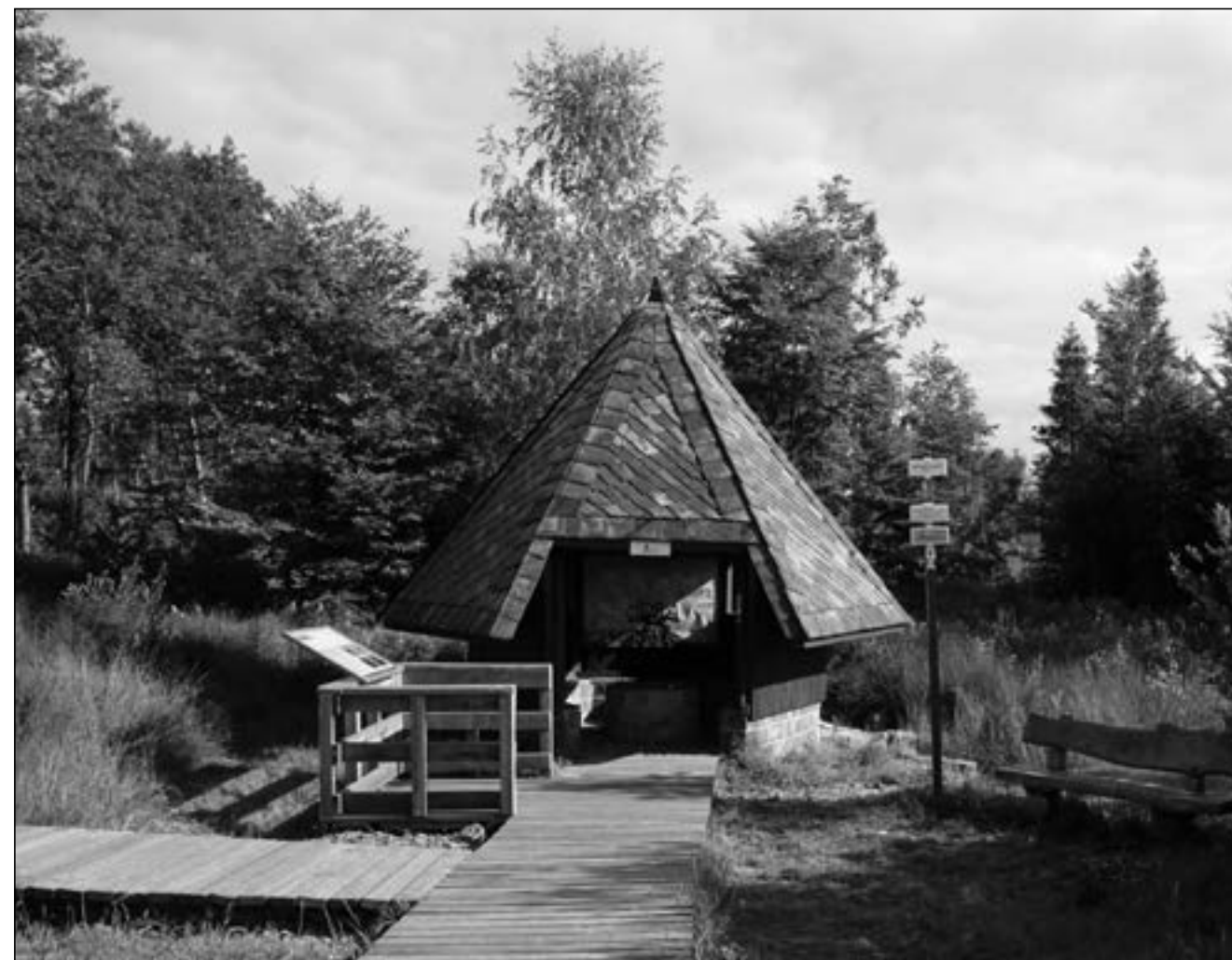
Nové pokrytí altánu břídlíci v červnu 2022. Foto Radim Jarošek.
