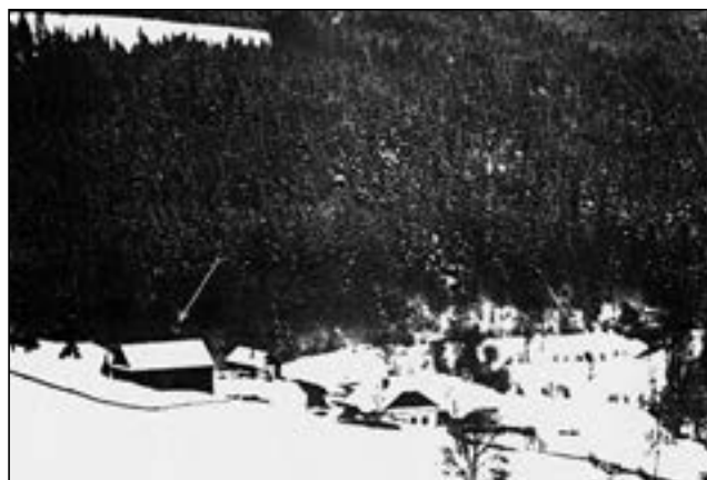
Okolí Dolního mlýnka čp. 50 na Něčíně ve 20. letech 20. století za majitele Adolfa Sauera. Nalevo vzadu budova pily – vyznačena šipkou. Archiv městyse Spálova.
